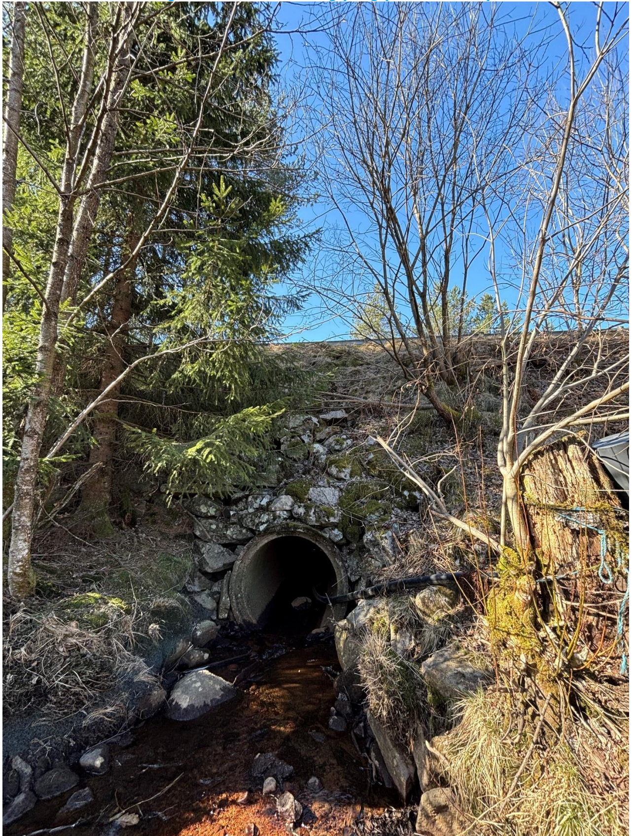
Bilde 1: Bekk i rør – sørlig del av eksisterende vegfylling (ca. Profil 1840)
