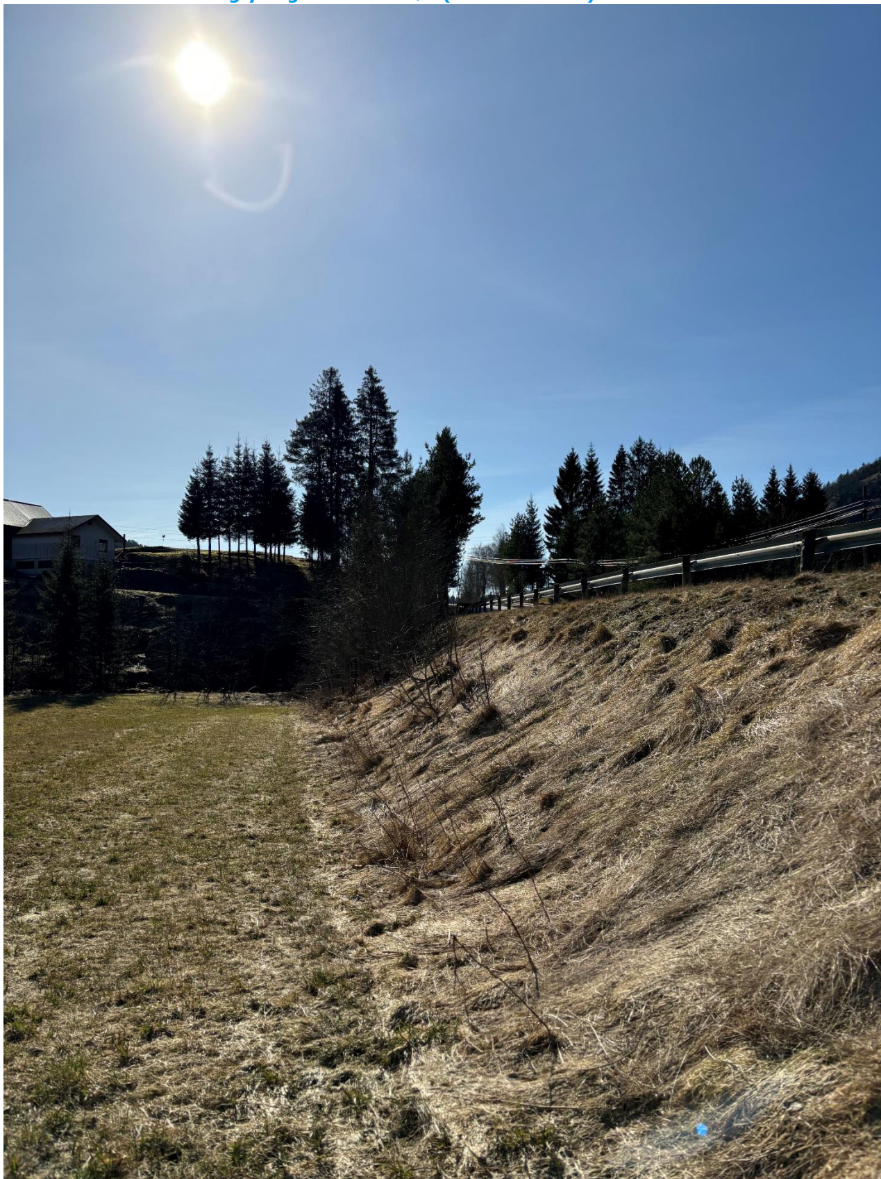
Bilde 3: Eksisterende vegfylling – sett mot sør (ca. Profil 1920)
