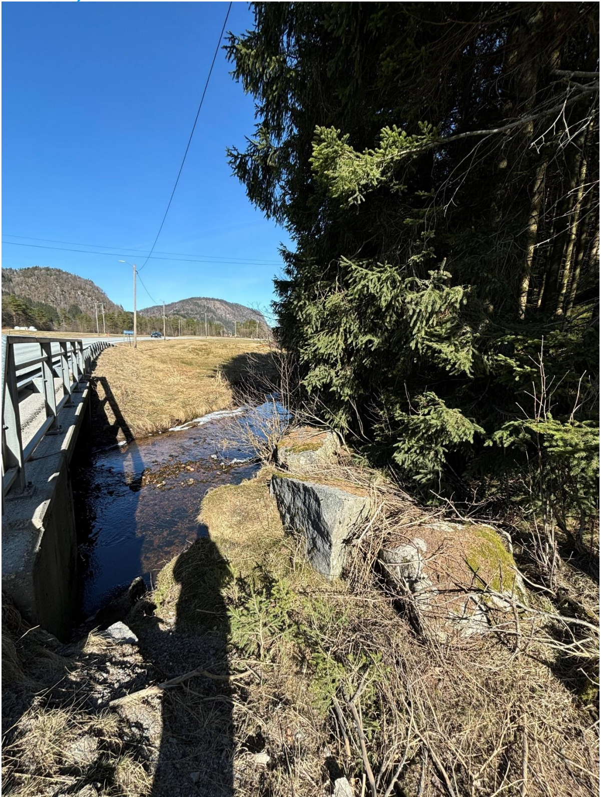
Bilde 4: Plassering av nordligste brufundament – sett mot nord. Bergskjæring i sør. (ca. Profil 2030)
