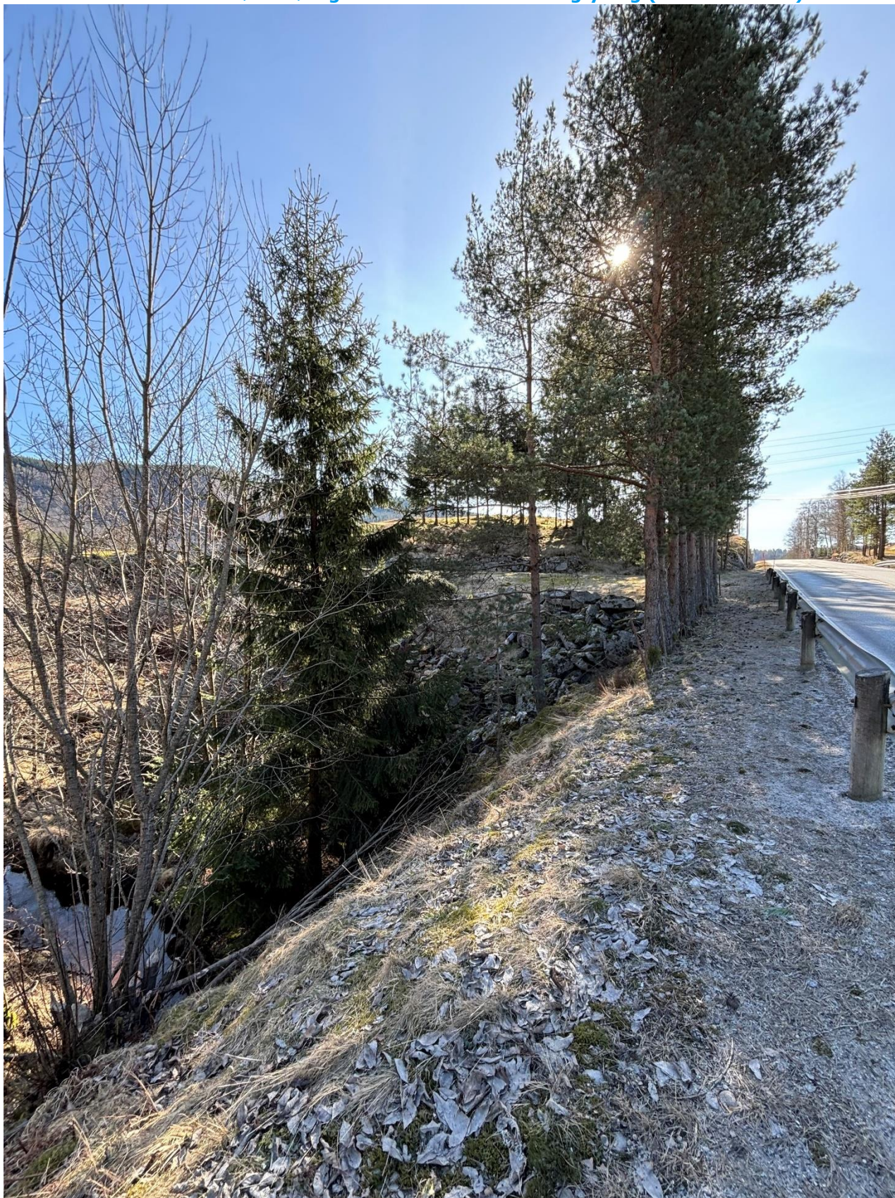
Bilde 2: Overside bekk i rør – sørlige del av eksisterende vegfylling (ca. Profil 1850)
