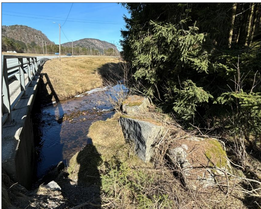
Figur: Eksisterende bro med bekk under fylkesvei
