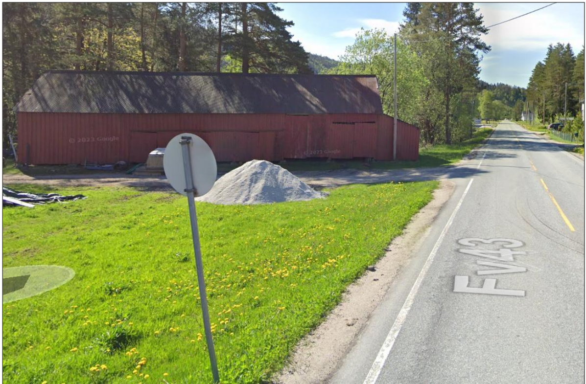
Figur: Bygning øst for Fv43 som kommer i konflikt med planlagt gang- og sykkelveg. Kilde: Google maps
