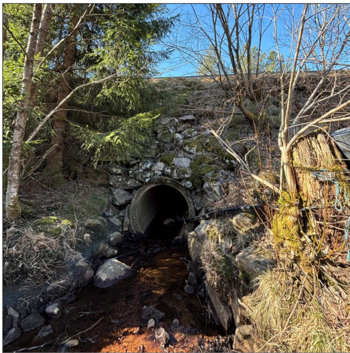
Figur: Bekkeløp i kulvert under fylkesvei. Kilde: Rambøll Norge AS
