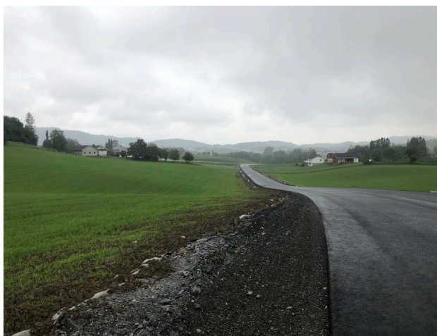
Figur 2: Første vekstsesong. Asfaltert anleggsveg med duk som går helt ut til siden.
