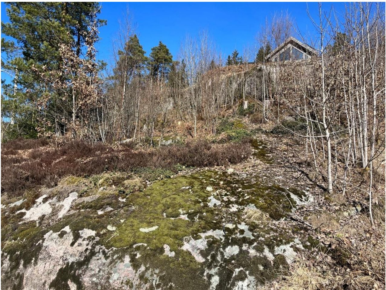
Figur 13. Overkanten av skjæring 1 med svabergflate og tynt løsmassedecke.
