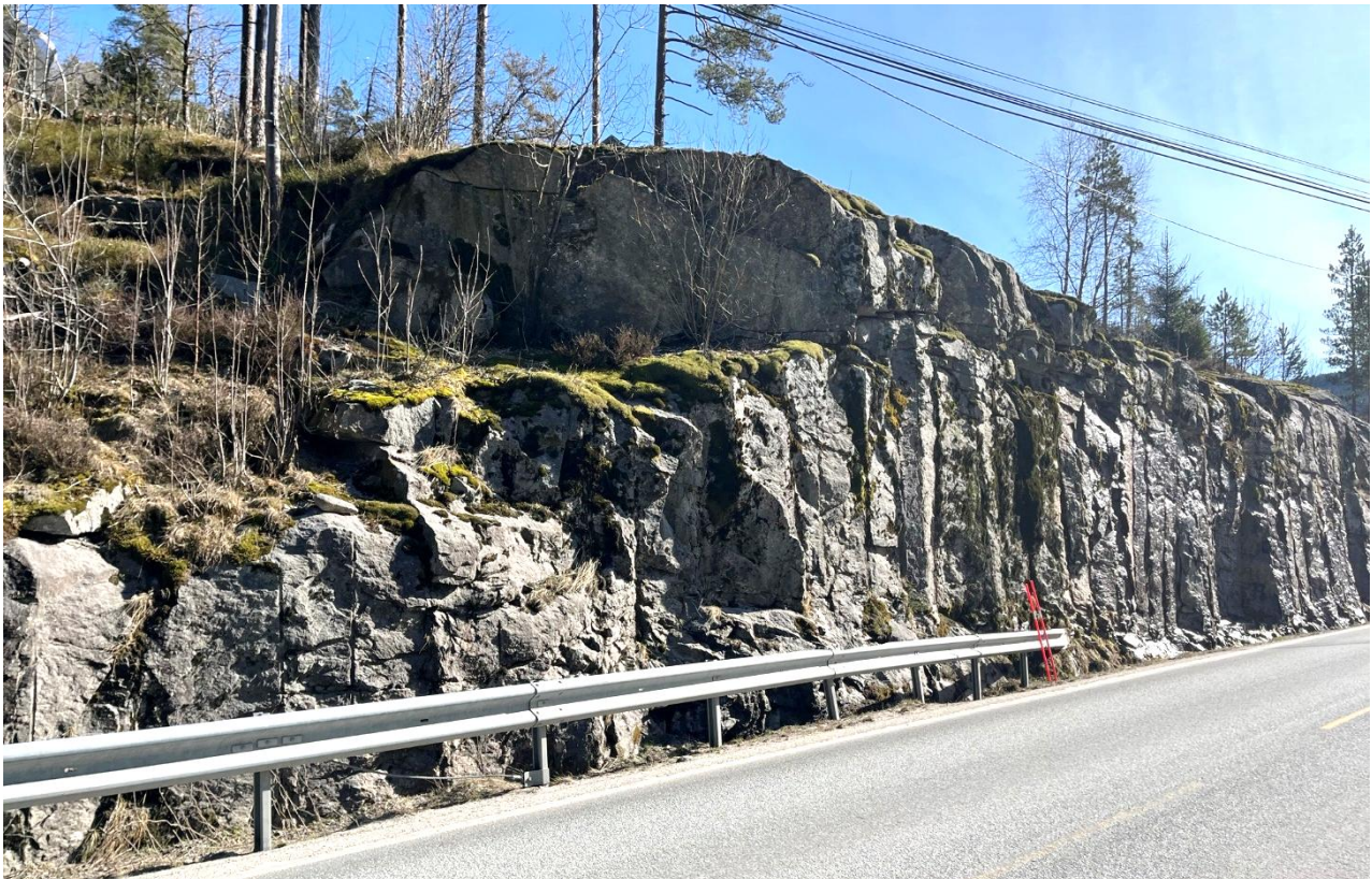
Figur 11. Detaljbilde av skjæring 1 sett fra nordvest.
